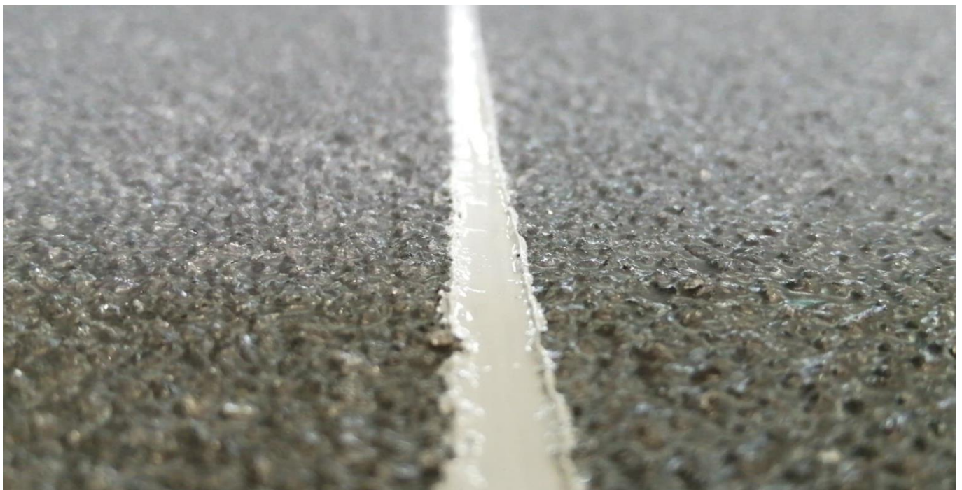
Dylatacja wykonana z poliuretanowego kitu uszczelniającego na Krytej kracie Evergrip
