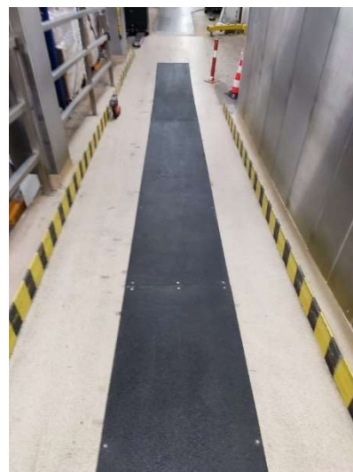
Mata antypoślizgowa z bardzo chropowatą powierzchnią ułatwiająca poruszanie się po pochylni
