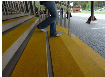
Cała powierzchnia stopni zabezpieczona pasami antypoślizgowymi w kolorze żółtym
