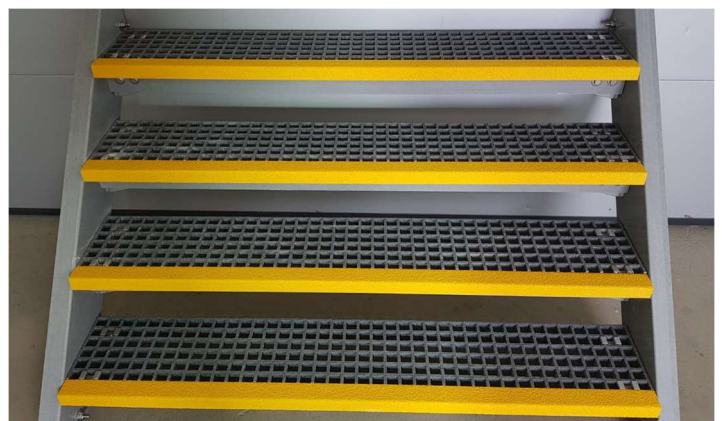
Ciąg schodowy w całości wykonany z odpornego na korozję kompozytu
