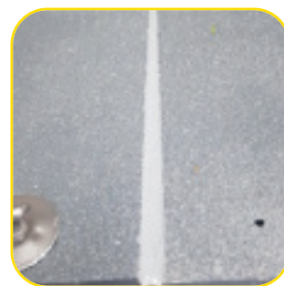
4. Po wyschnięciu uszczelniacza podłoga jest gotowa do użytkowania
